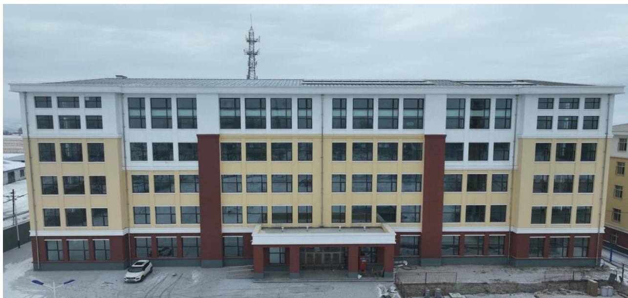
图 40：学校新建实训楼
